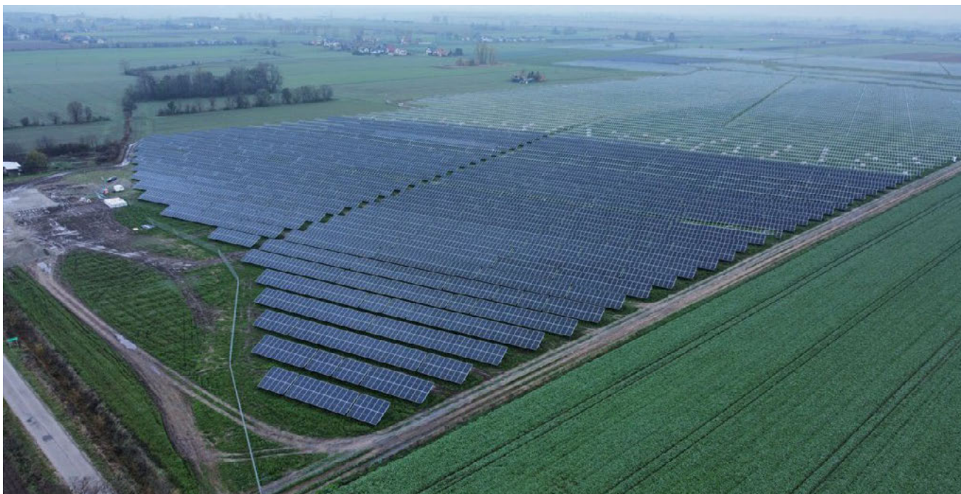
Stan budowy projektu Kleczew Solar & Wind – listopad 2022
