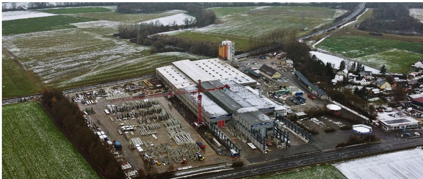
Fabryka FTO Fertigteilewerk Obermain (mat. Pekabex)
