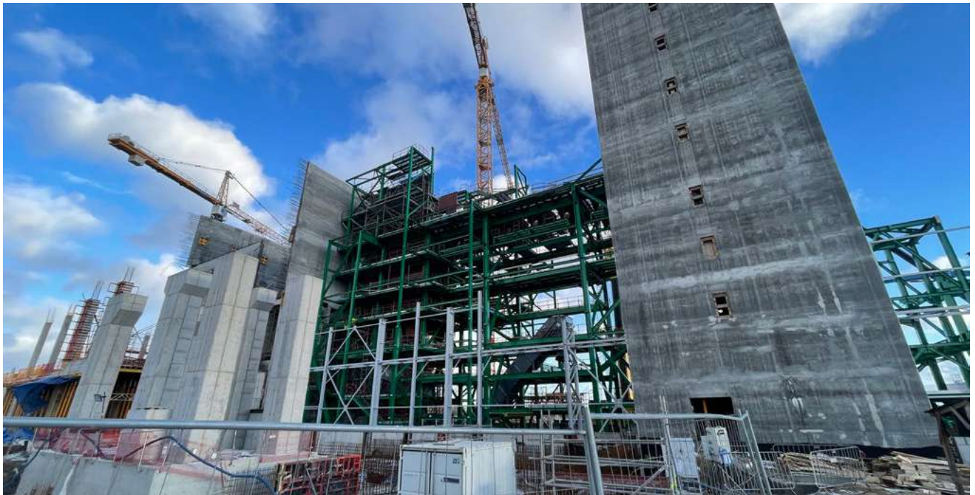
Budowa ITPO w Olsztynie
