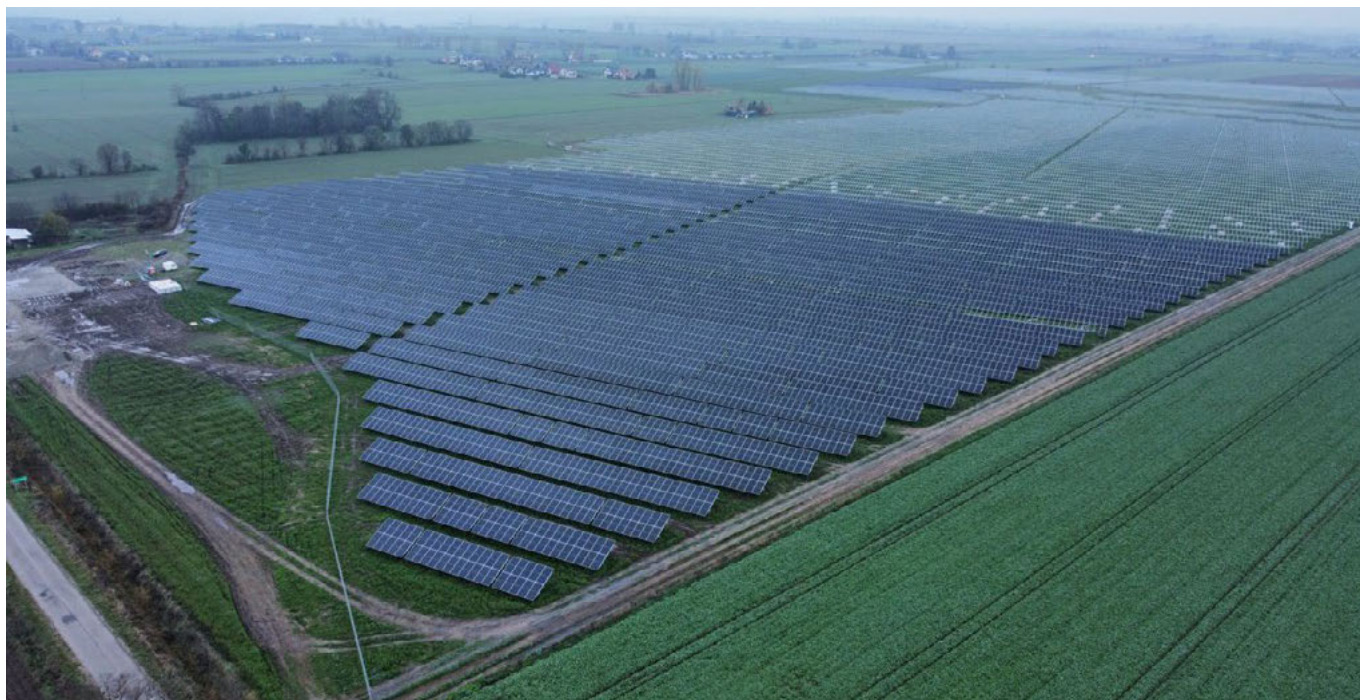
Stan budowy projektu Kleczew Solar & Wind – listopad 2022
