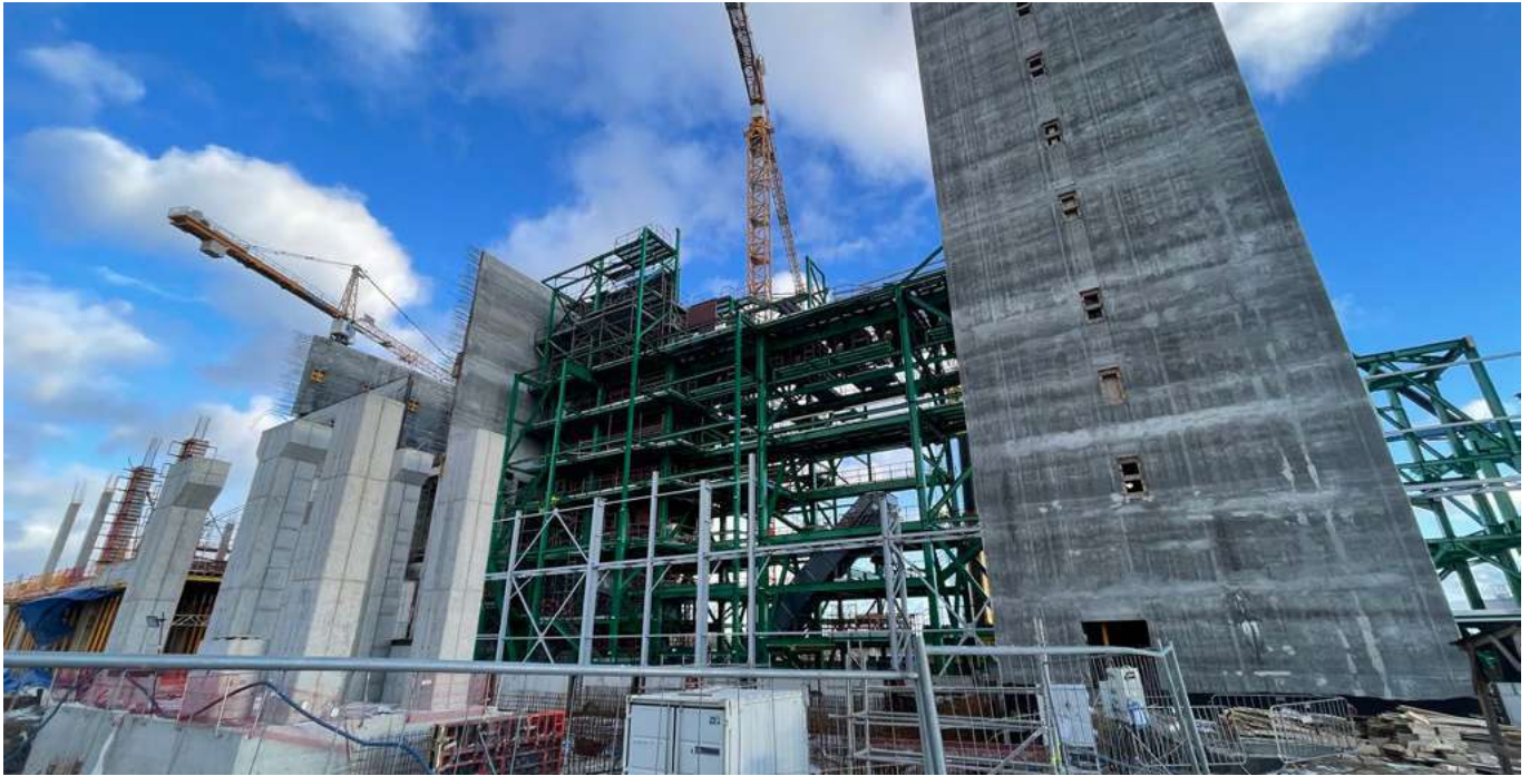
Budowa ITPO w Olsztynie
