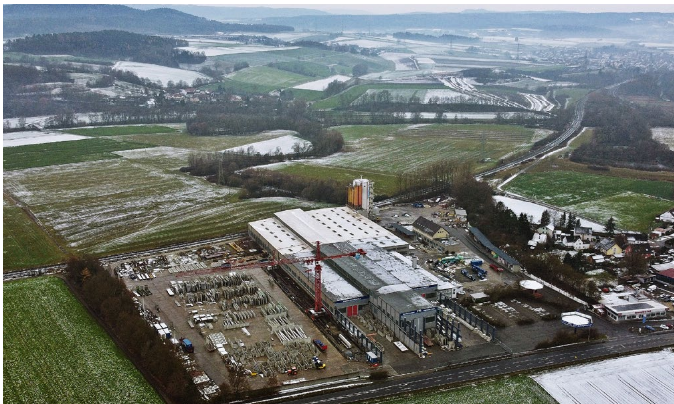
FTO Fertigteilewerk Obermain factory (mat. Pekabex)
