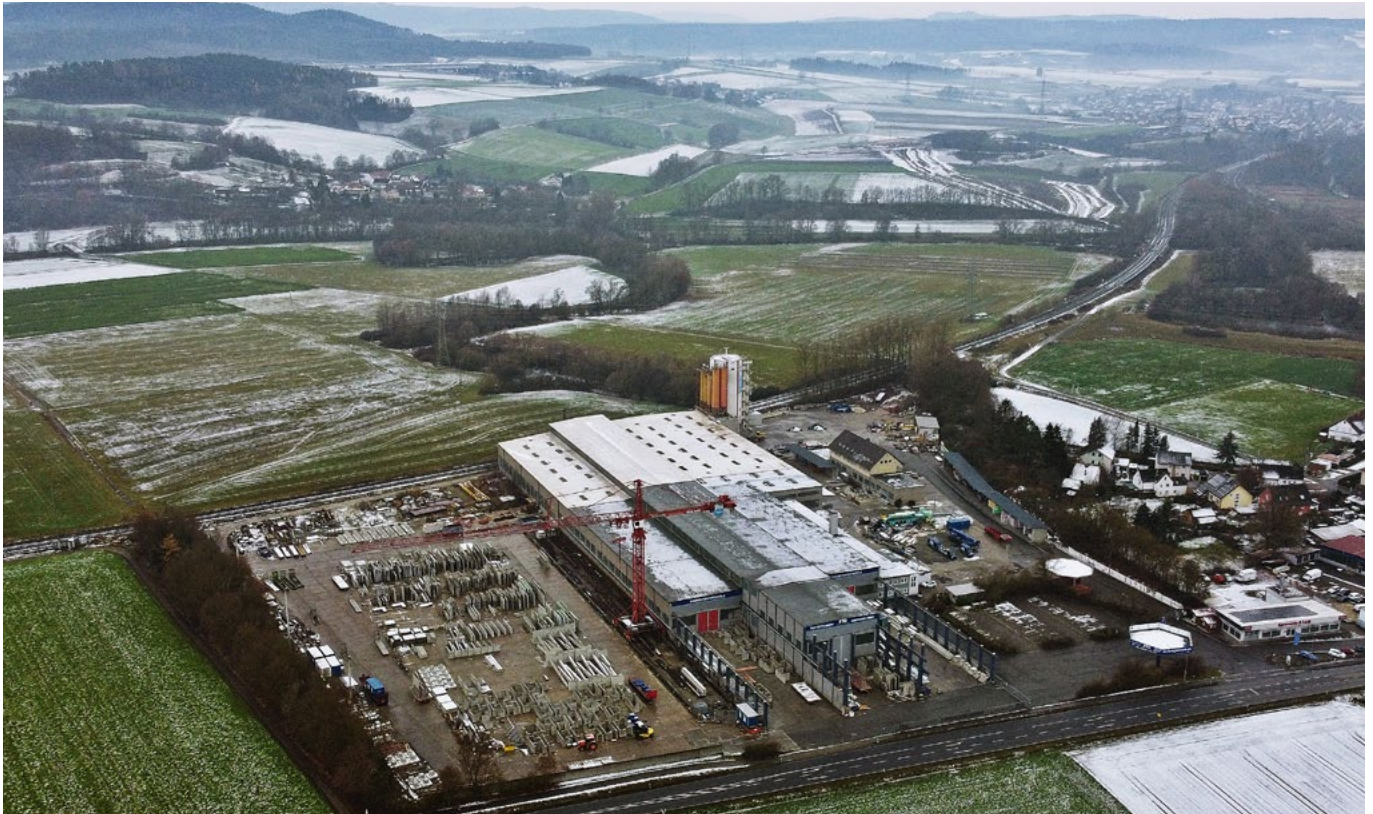
FTO Fertigteilewerk Obermain factory (mat. Pekabex)
